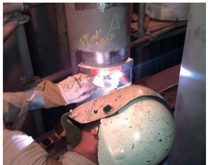
Opgeleide specialist die een tubeskin thermometer installeert
